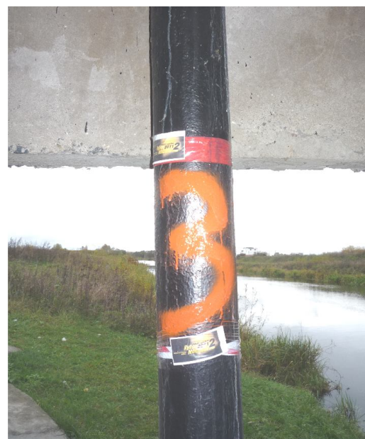
рис. 6: Символ КП нанесенный краской на техногенный объект (ЛЭП)
